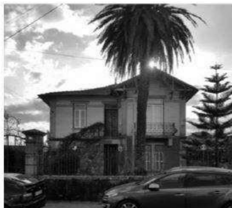
Figura 1 - Fachada Frontal da Propriedade
